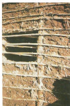
Parede feita de lama.
